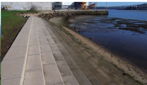
ESI 8B: Estrutura artificial protexida
